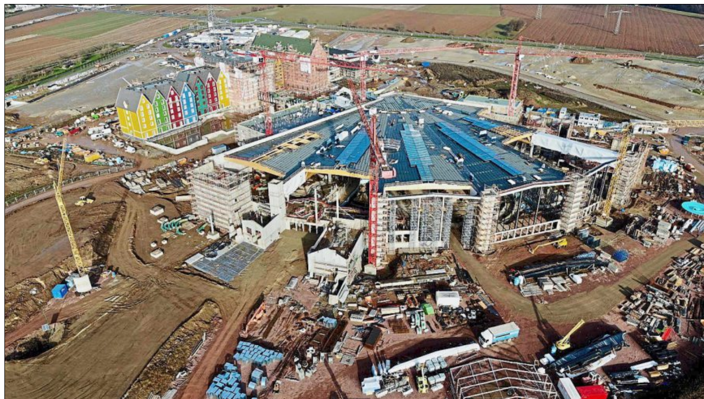
THOST ARBEITET FÜR PROJEKTE ganz in der Nähe und in der weiten Ferne: So für den Wasserpark in Rust ...
