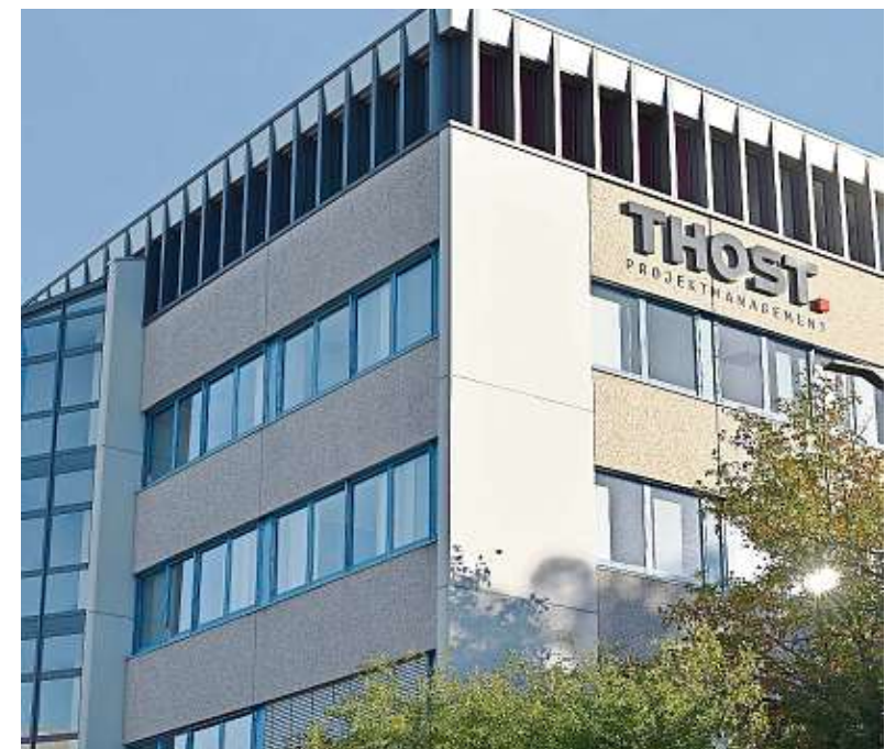
Der Firmensitz von Thost Projektmanagement auf der Wilferdinger Höhe.
